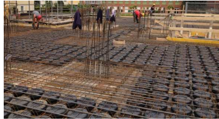
Posa armatura superiore
