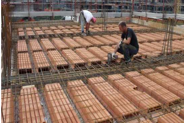
Conformazione delle travi e posa dell'armatura di ripartizione
