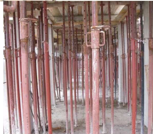
Casseratura travi molto spesso ricalate Imposta travi rompi tratta e puntellatura
