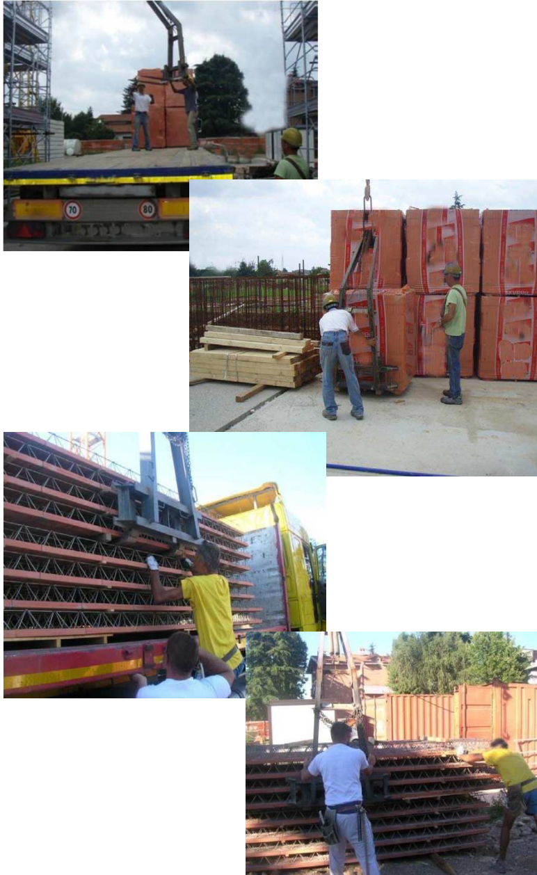
Accatamento dei travetti e interposti in cantiere
