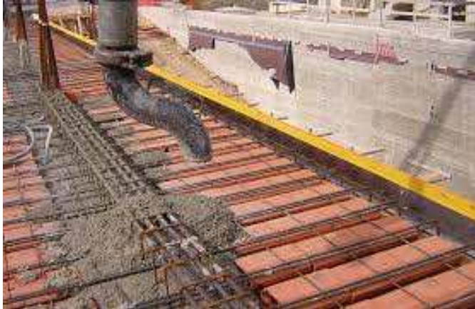
Getto del calcestruzzo
