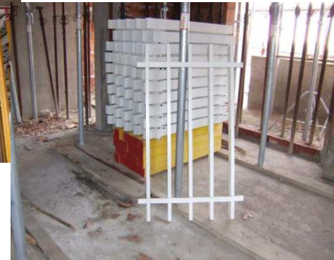
Con i moderni sistemi di cassetta è possibile anche il disarmo parziale e riutilizzo ai piani superiori. Il disarmo è comunque veloce e in sicurezza
