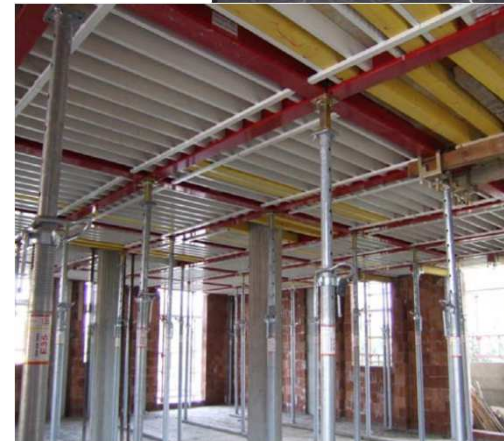
Casseratura continua con puntellazione dal basso. Garanzia di sicurezza in cantiere!
