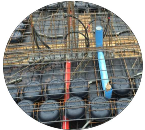
Particolari di impianti elettrici ed idrici nei solai
