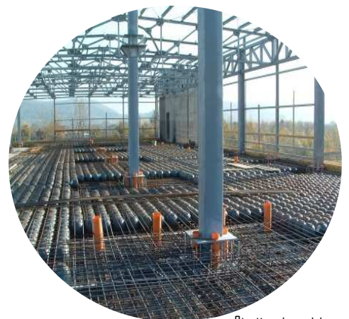
Struttura in acciaio
